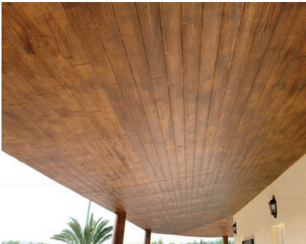
Acabado final en barniz. / EN.Final finish with varnish. / FR.Finition vernis. / DE.Betonbau mit Lackanstrich.
