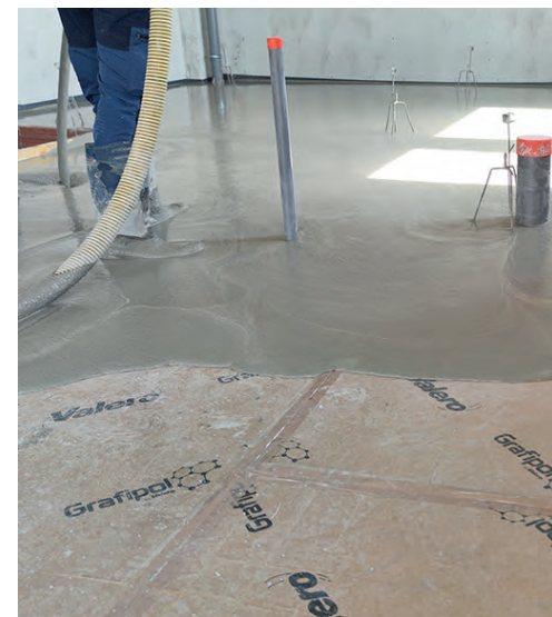
Vertido directo de mortero autonivelante.
