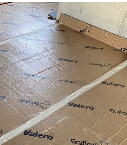
Elevación del roll en el perímetro (e=10-15mm)
