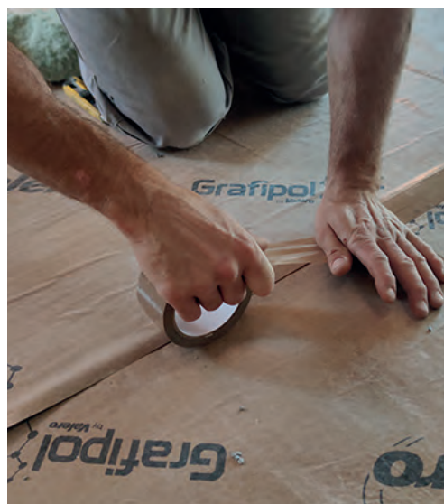
Unión entre paneles mediante cinta adhesiva.
