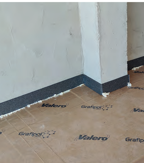
Banda desolidarizadora perimetral (e≥20mm)
