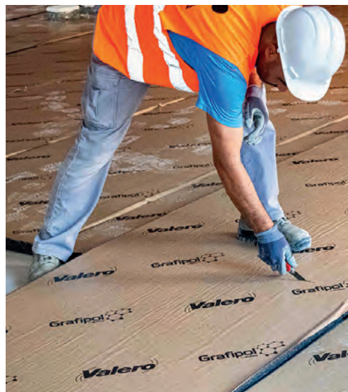
Corte de los paneles mediante cúter.
