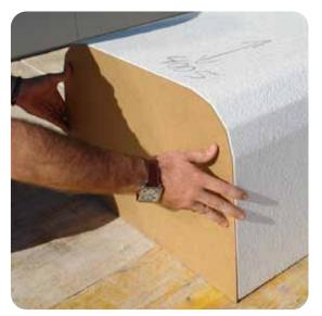
Posicionado el EPS, colocamos la madera agarrando siempre lateralmente, nunca de los cortes o juego de la madera.
