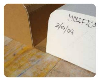
Paralelamente al replanteo colocamos el siguiente casetón, posicionando el ala de la segunda madera.
