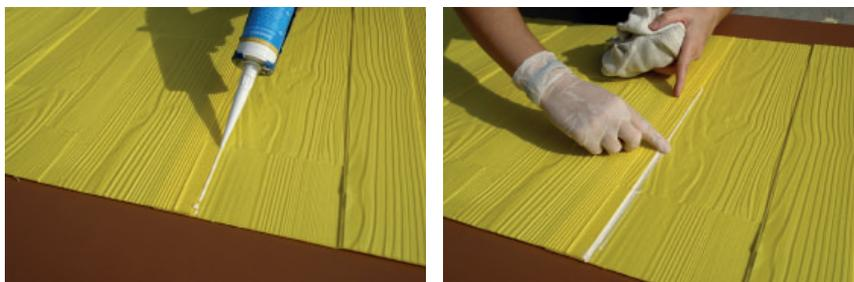
5.- Werden die LHV Formliner mit Sprühkleber auf die Schalungsplatten gebracht und stumpf gestossen ohne die Stossfugen zusätzlich zu schließen, besteht die Gefahr, dass Beton hinterläuft.
