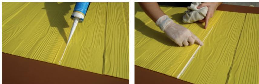
5.- Assemblage des panneaux LHV Formliner sans des éléments de scellage, Il faut signaler que son empreinte sera visible sur la finition béton et il est possible que le béton entre le LHV Formliner et le coffrage.
