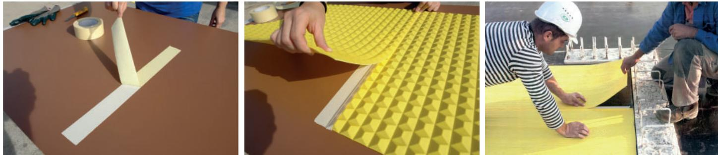
4.- L'enlèvement du LHV Formliner. L'enlèvement est facile à faire, il suffit de tirer par n'importe quelle extrémité. Les restes de colle sur le coffrage s'enlèvent avec du solvant ou produit similaire pour nettoyer le coffrage.
