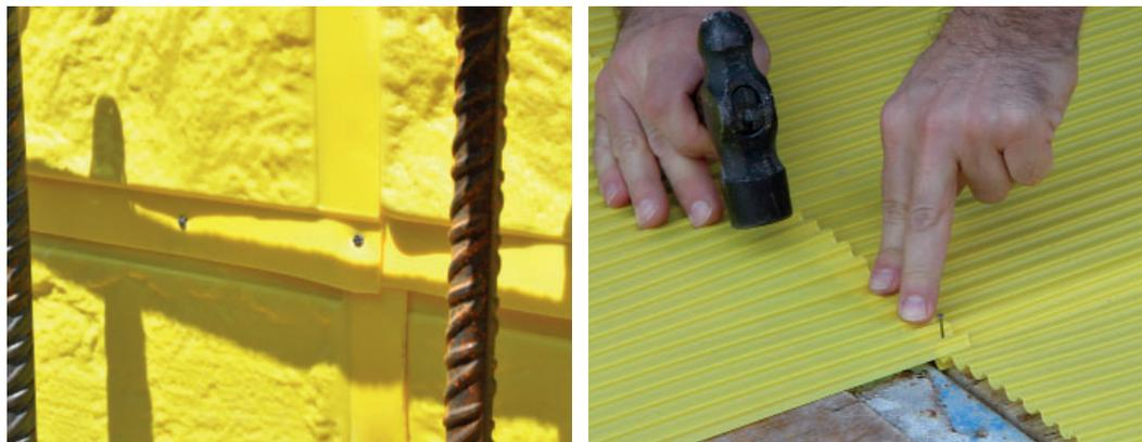
3.3.- Fixation avec du scotch à doublé face; Appliquer du scotch à double face autour de tout le périmètre du LHV Formliner et en bandes tous les 20/30 cm, si nécessaire. Procédez à sa fixation sur le coffrage.
