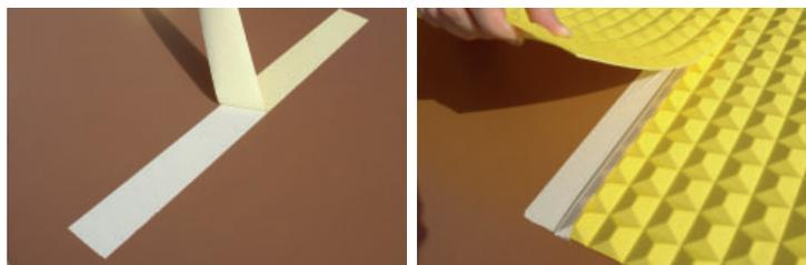
4.- Utilisation de silicones spécifiques pour le scellage des joints et contact avec le béton Il faut signaler que son empreinte sera visible sur la finition béton.
