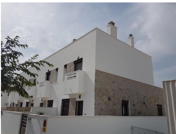
Fig. 6: Edificación 2: aislamiento térmico reflexivo multicapa
