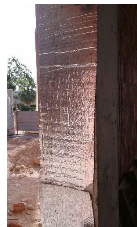
Fig. 7: Puesta en obra aislamiento
