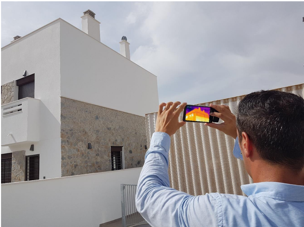
Fig. 1: Imagen de la inspección termográfica in situ
