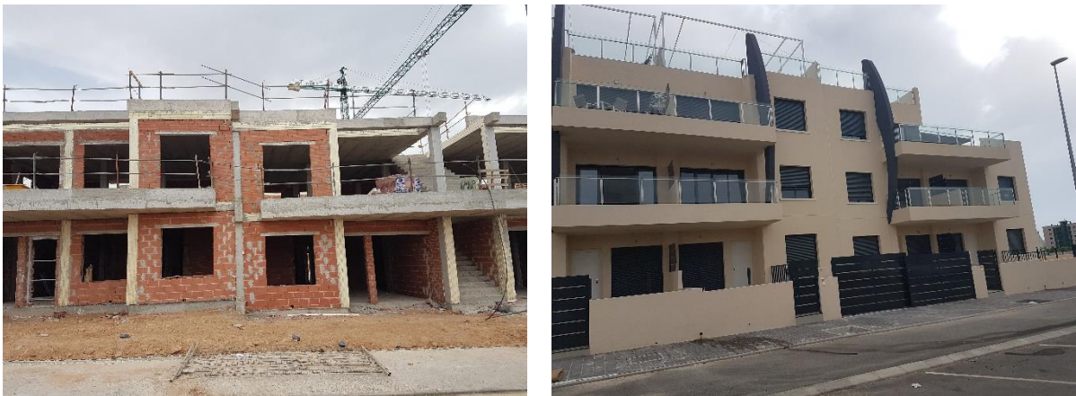
Fig. 5: Edificación 1: aislamiento de EPS Valero (Fase ejecución y obra terminada)
