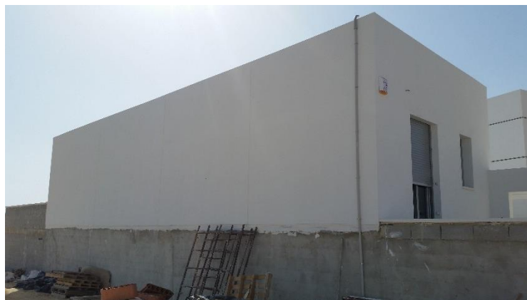
Fig. 5: Edificio 2: con aislamiento térmico en los frentes de forjado.
