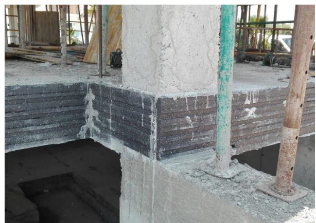
Fig. 20: Producto TR-Canto forjados colocado en obra (3).
