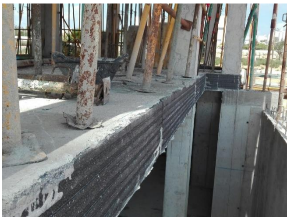
Fig. 19: Producto TR-Canto forjados colocado en obra (2).
