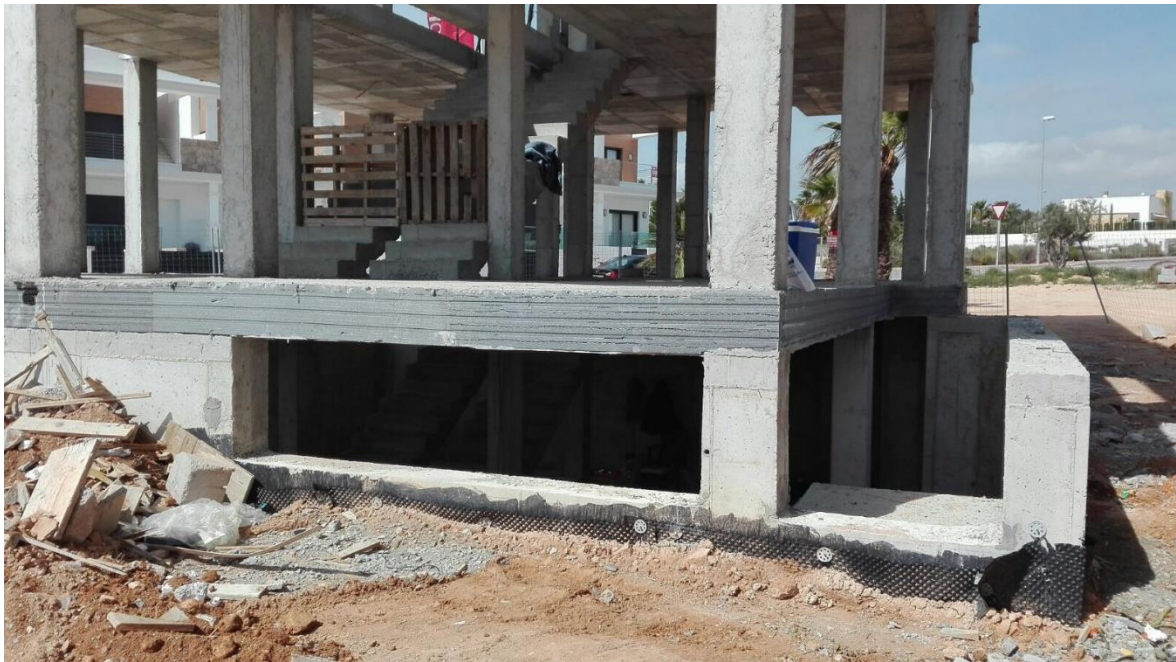
Fig. 18: Producto TR-Canto forjados colocado en obra.
