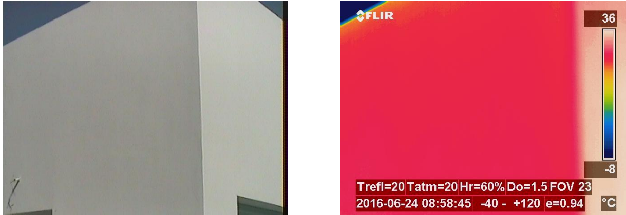
Fig. 15: Ausencia de puentes térmicos en fachadas frontal y lateral del edificio 1.
